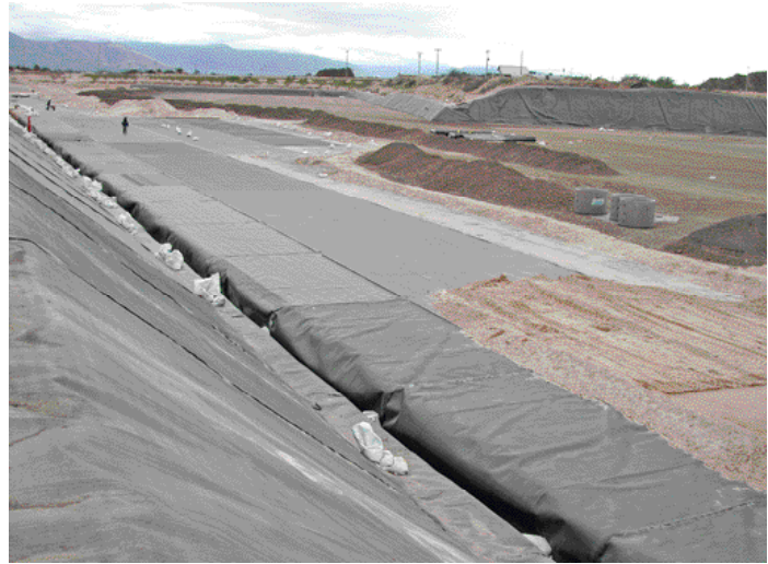
Monorelleno de La Farfana en su etapa de construcción.
