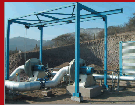
ECB del Relleno Sanitario Santa Marta – Santiago de Chile: Tres módulos de 1000Nm 3 /h c/u (izquierda) y Sopladores Biogás (derecha)
