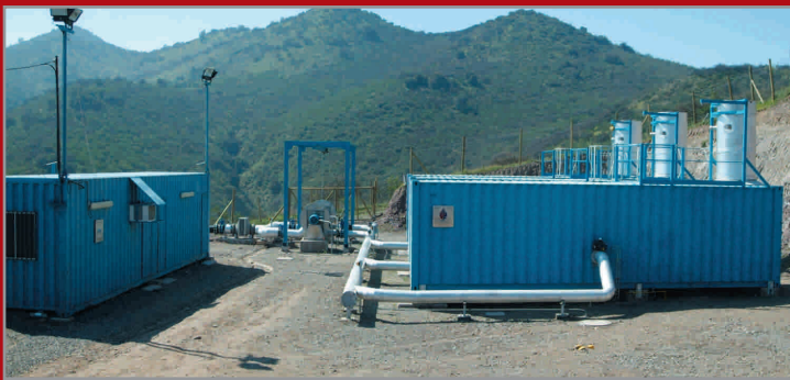
ECB del Relleno Sanitario Santa Marta – Santiago de Chile: Tres módulos de 1000Nm 3 /h c/u (izquierda) y Sopladores Biogás (derecha)
