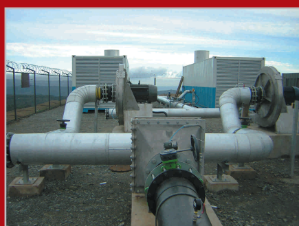
Entrada ECB Rellenos Sanitarios El Molle Valparaíso - Chile
