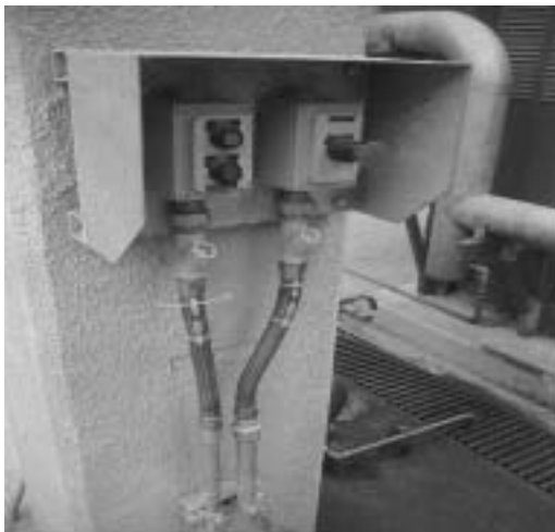
FOTOGRAFIA 1: Interruptores EEx para zonas de niveles 1 y 2.
